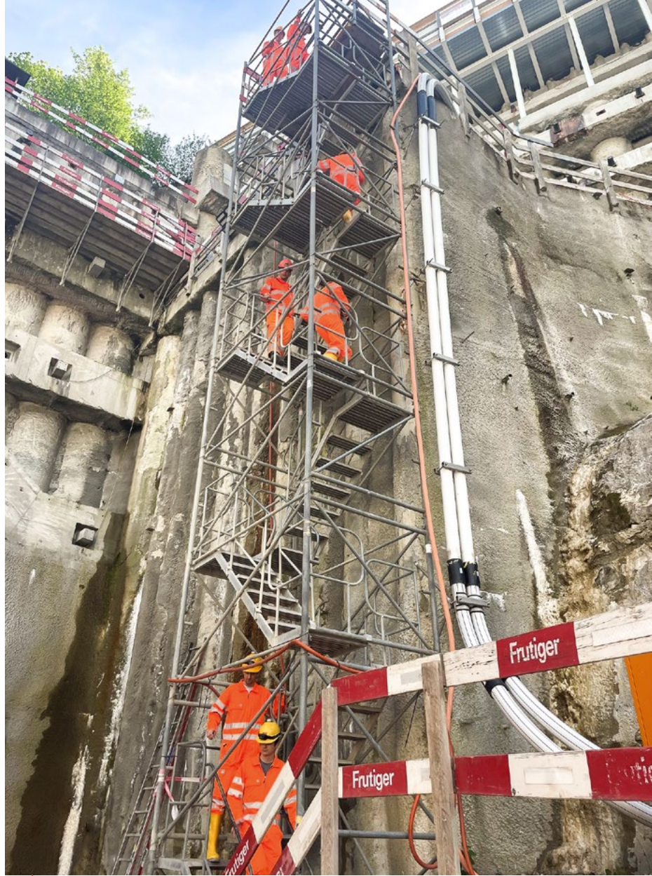
Abstieg zur Baugrube
