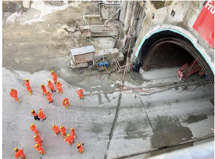
Die Baugrube im Wildpark
