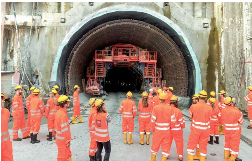
Point d'entrée vers les tronçons Bierhübeli et Henkerbrünnli
