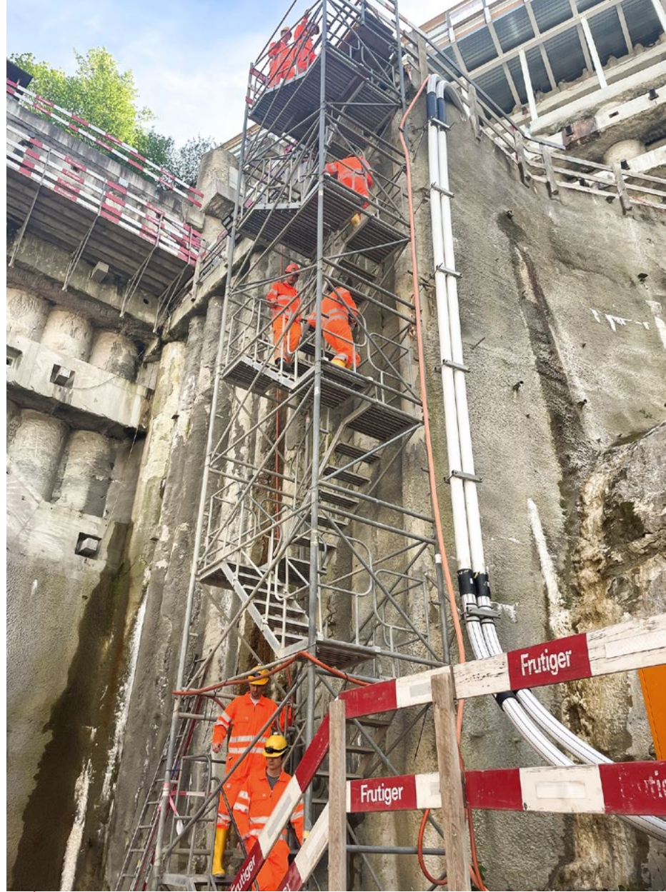
Point de descente dans la fouille
