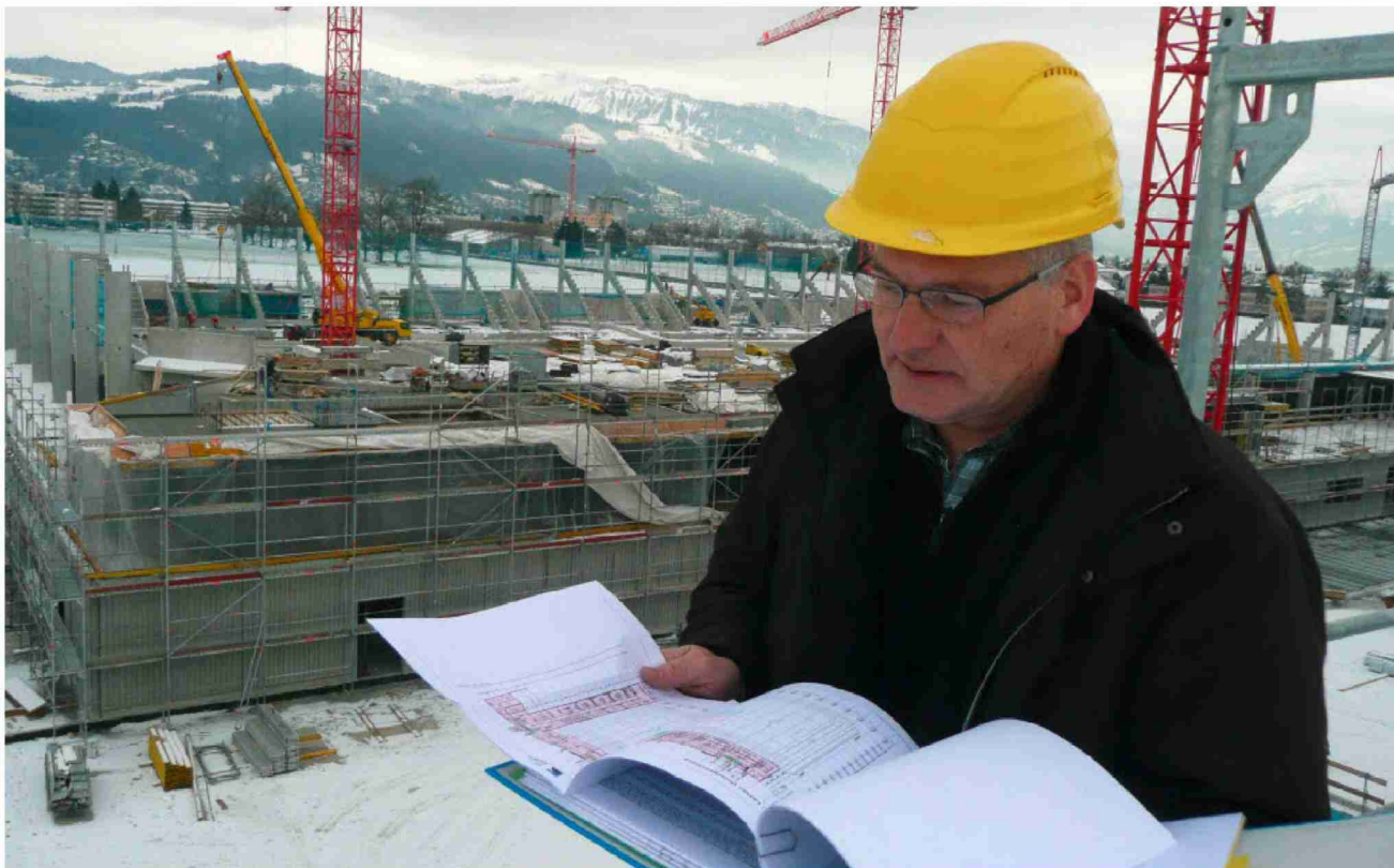
Thomas Gruber von der Theiler Ingenieure AG Thun bei seiner täglichen Arbeit auf der Baustelle Stadion Thun-Süd. Ingenieure wie er fehlen zur Zeit vielen Firmen in Thun und Region. Dino Dal Forno
