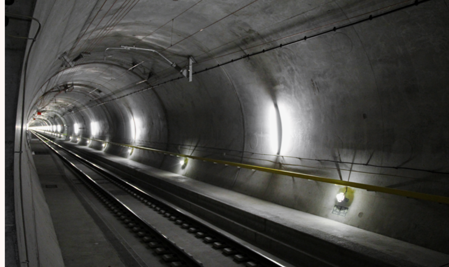
Blick in den betriebsbereiten Teil des Gotthard-Basistunnels.
