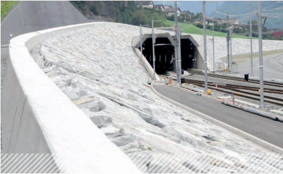
In Erstfeld befindet sich das Nordportal des 57 Kilometer langen Gotthard-Basistunnels.
