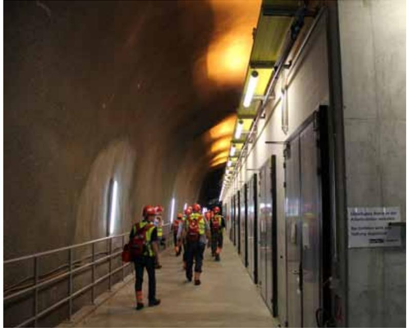
den 1990er-Jahren 300 Meter über dem eigentlichen Tunnelverlauf ein fast 6 Kilometer langer Sondierstollen gebohrt. Von dort aus wurden weitere Bohrungen in Richtung des geplanten Tunnelverlaufs durchgeführt. Erst als gesichert war, dass die Mulde im Bereich des Tunnelverlaufs aus Dolomitmarmor ohne Wasserdruck bestand, konnte mit den eigentlichen Arbeiten am Basistunnel begonnen werden.
