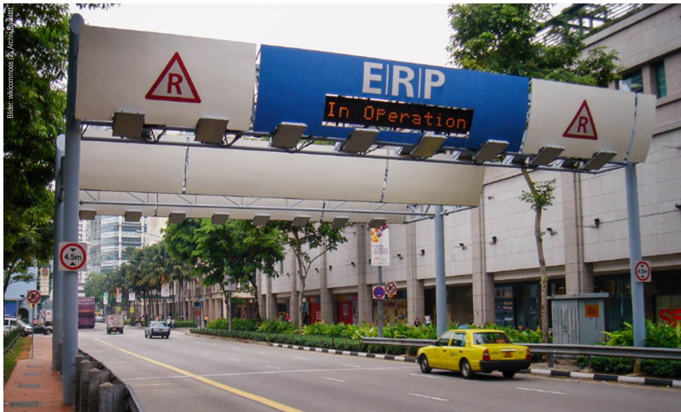
Road Pricing in Singapur: Die Erfassung der einzelnen Fahrzeuge erfolgt automatisch über einen Funkbalken, der die erhobene Strassengebühr anzeigt.
