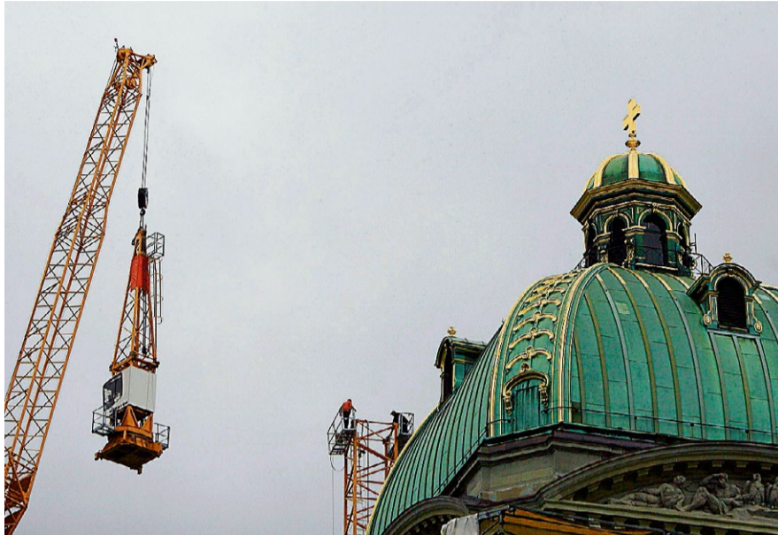
Den Preiskampf gibt es nicht nur im Tessin: Bauarbeiten am Bundeshaus. Foto: Keystone
