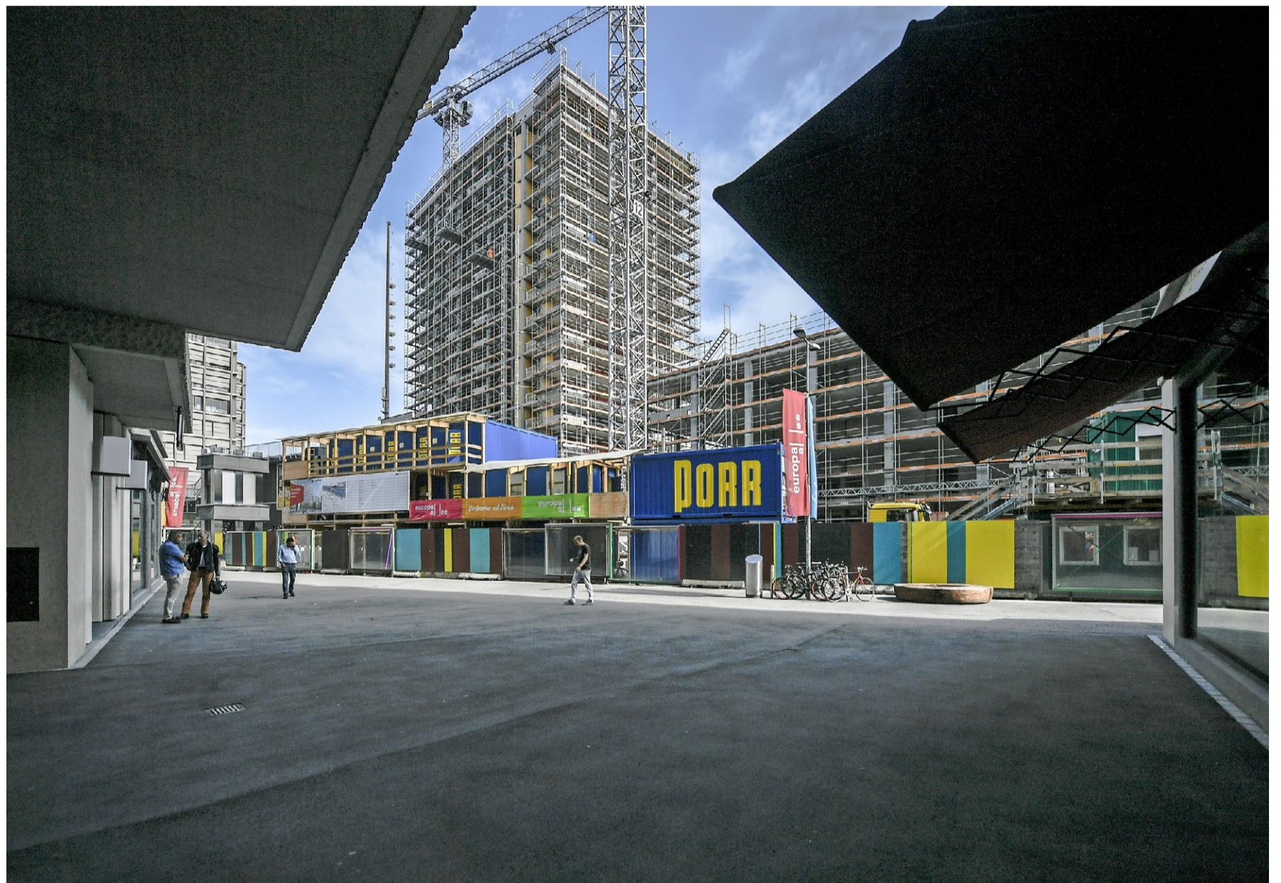
Der 53 Meter hohe Rohbau auf dem Bau Feld F der Europaallee steht bereits. Die Fassade wird halbfertig angeliefert. Foto: Doris Fanconi
