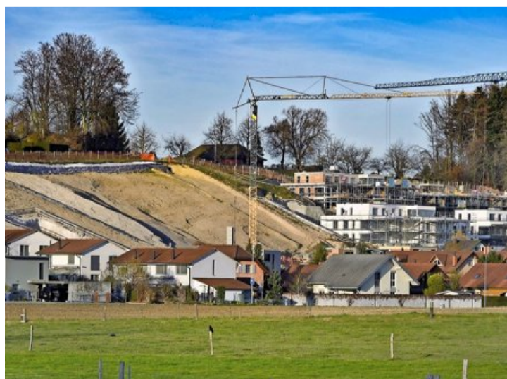
Es wird gebaut und gebaut am Muniberg. Dieses Bild zeigt den Zustand von November 2015. Bereits wurden weitere Etappen gestartet. Thomas Peter
