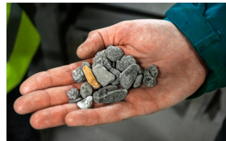
Das grosse Sieben: Der gebrochene Mischabbruch durchläuft diverse Siebanlagen und wird in einzelne Kornfraktionen klassiert.
