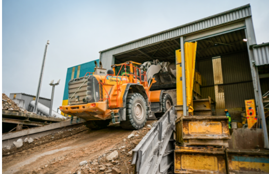
Oben: Ein Radlader beschickt den grossen Prallbrecher mit Bauschutt.
