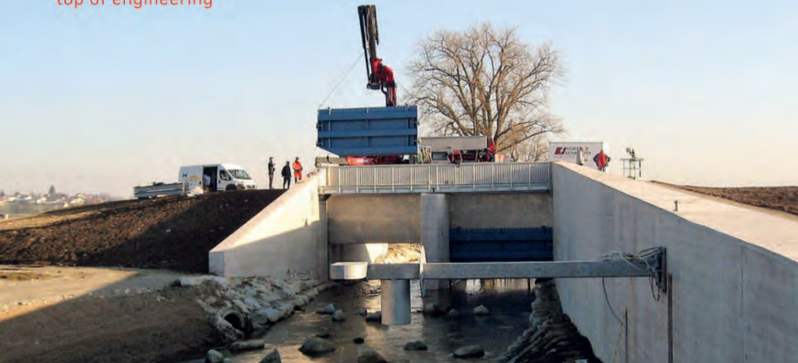
Durchlassbauwerk, Holinger AG und adaptiertes Logo.
