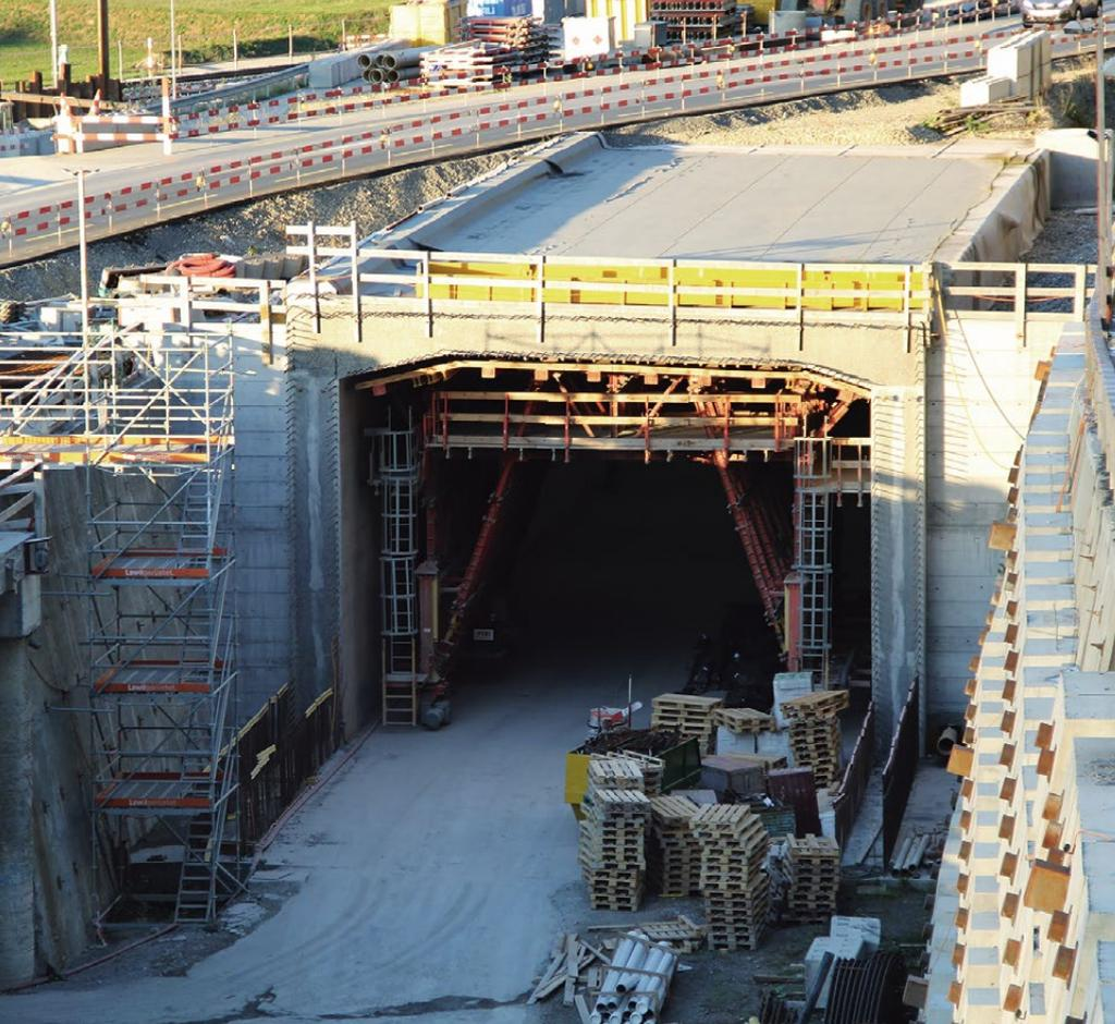
Der Tagbautunnel, rechts im Bild sind die Felsanker für die Hangsicherung zu sehen.
