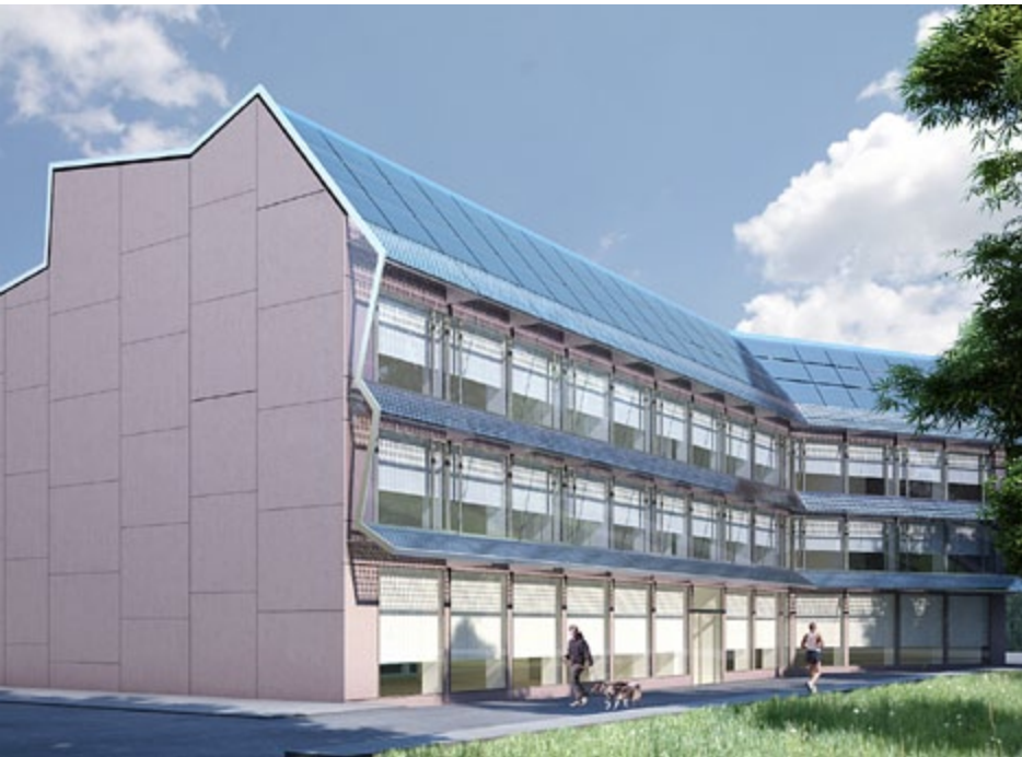
Abb. 4: Die Südfassade: Gut sichtbar sind das Solarkollektorenfeld auf dem Dach und die Photovoltaik-Module, die in die Fassade integriert sind. (Visualisierung: Stücheli Architekten)
