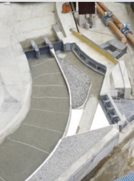
Modellversuche für die Erweiterung des Laufkraftwerkes Lavey an der Rhone im Wallis.
