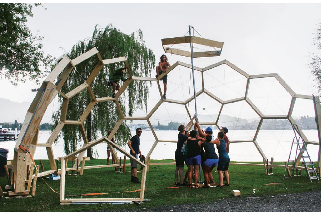
Bühnenüberdachung NON-OpenAir Meggen, Montage mit Stange.
