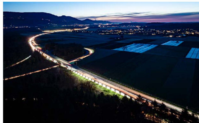
L'ASTRA Bridge sur l'autoroute A1 permettant de maintenir le trafic routier pendant l'exécution des travaux au-dessous du pont. Pour garantir le passage des véhicules sans restriction de vitesse, la rupture de pente a été optimisée par le rallongement et la réduction de la déclivité des rampes d'accès et de sortie.
