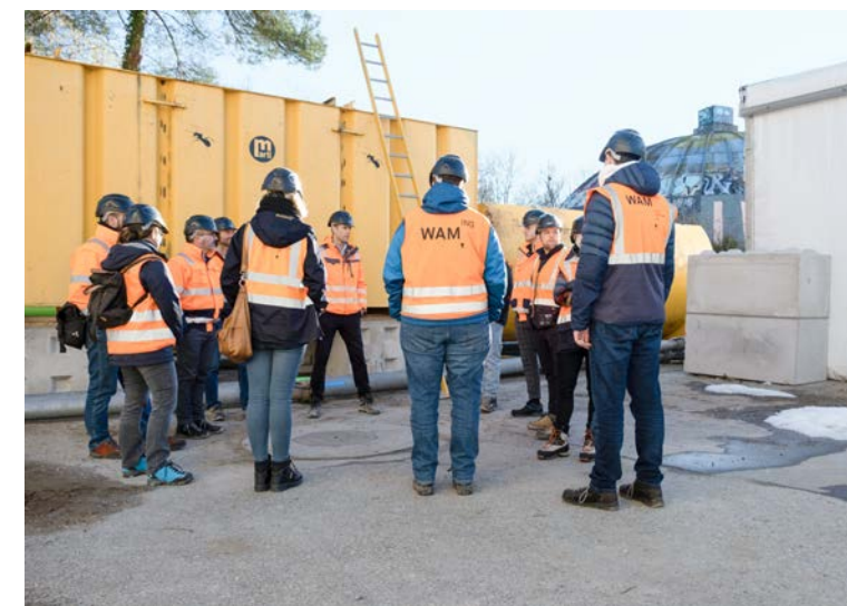
Inspection lors des travaux d'assainissement sur le site contaminé de l'usine à gaz du Sandrain à Berne
