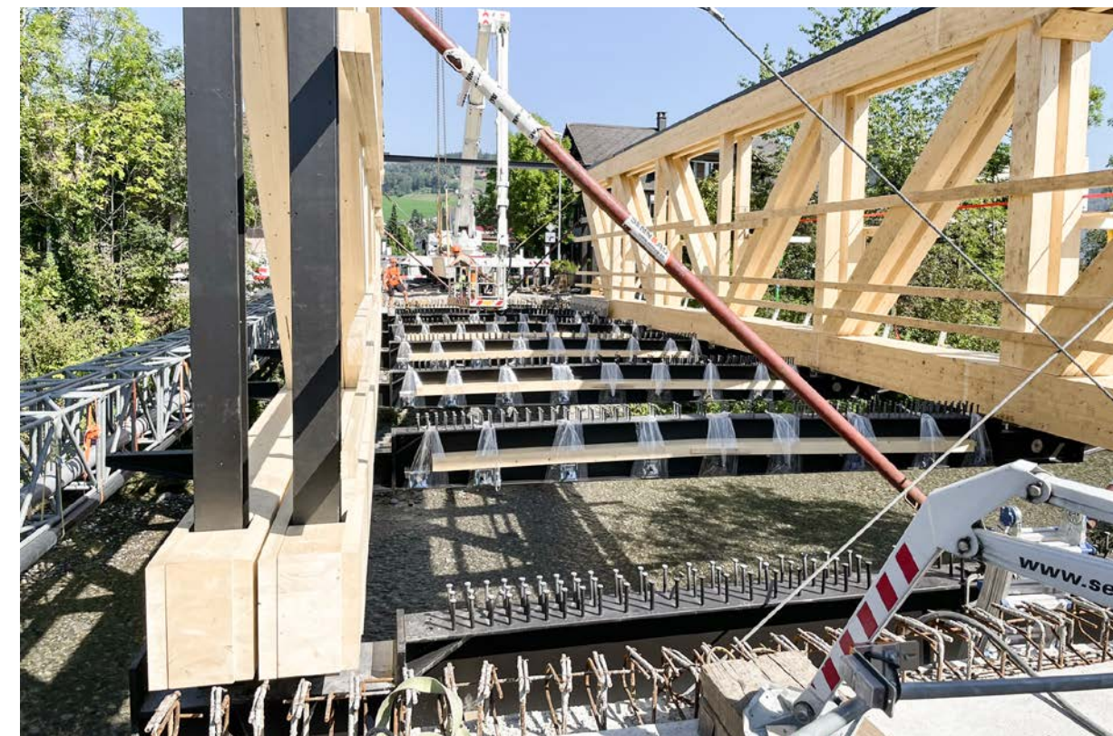
Construction d'un nouveau pont en bois, Steffisburg. Prestations de b+d: planification et direction des travaux de démolition de l'ancien pont, direction des travaux et direction générale des travaux lors de la construction du nouveau pont
