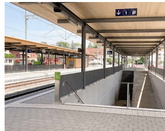
Transformation de la gare, Kirchberg-Alchenflüh. Prestations de b+d: planification générale et planification spécialisée des phases 31 à 53, direction des travaux et mesures de surveillance
