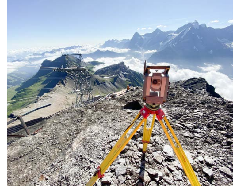
Construction du nouveau téléphérique, Schilthorn 20XX. Prestations de b+d: piquetage de chantier, mesures de contrôle et de surveillance
