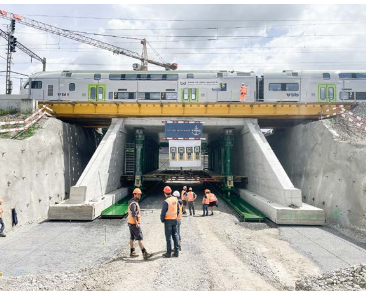
Nouvelle route de délestage nord, Münsingen: percée d'un nouveau passage souterrain sous la voie ferrée. Prestations de b+d: planification générale et planification spécialisée des phases 31 à 53, direction des travaux, mensuration de chantier et monitoring de la fouille
