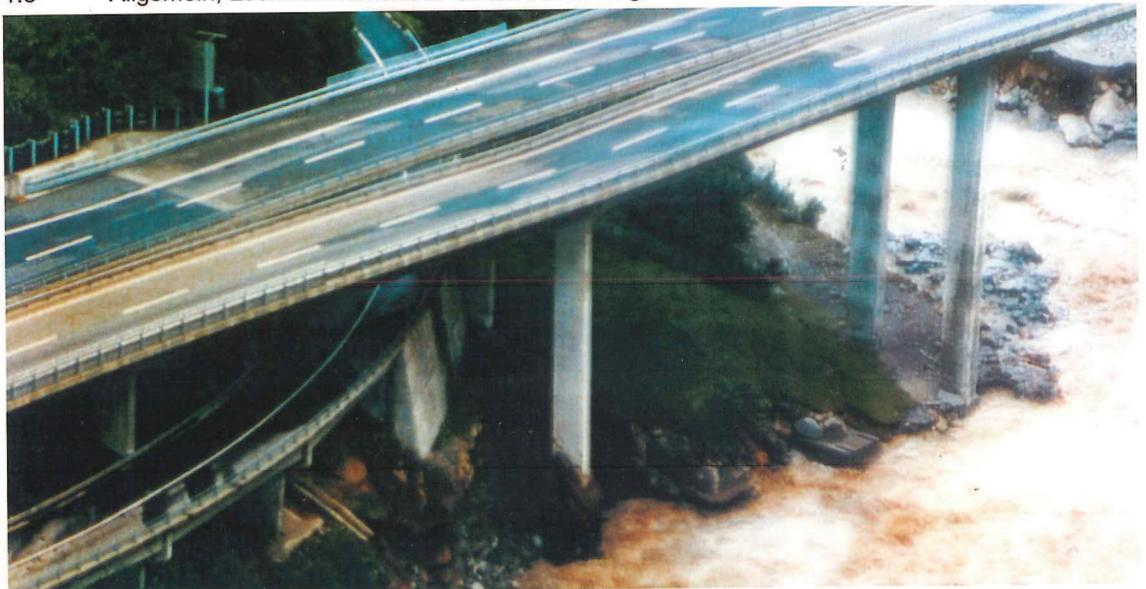
1.9 N2 Reussbrücke Wassen, Extremereignis Hochwasser 1987, Pfeilerabsenkung um 1.30m
