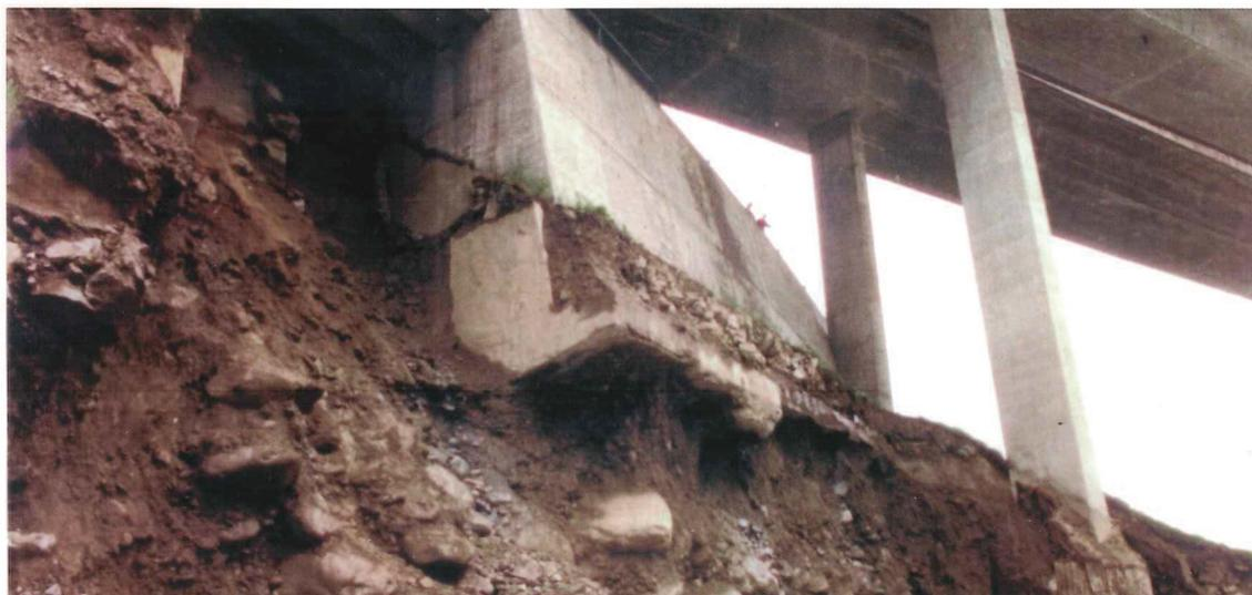
1.10 N2 Reussbrücke Wassen, abgesenkter Pfeiler und Überbau, Risse 15cm breit, Stützmauer Kantonsstrasse unterspült, Absturzgefahr
