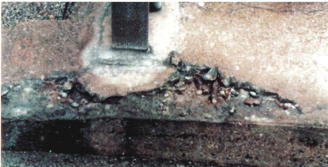
1.5 N2 Reussbrücke Felli, Schäden am Konsolkopf, Frosteinwirkung, Abplatzungen
