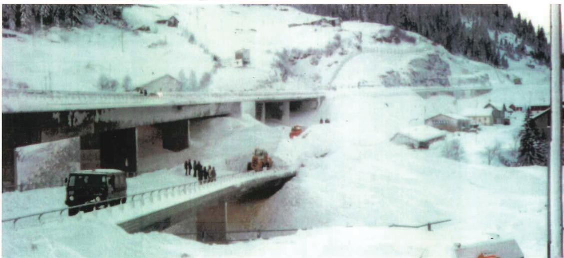
1.11 N2 Reussbrücke Wattingen, Einwirkung der Lawine Rohrbachlauri oberhalb Wassen. Grosser Lawinendruck auf die Brücke der Nationalstrasse und der Kantonsstrasse, 1981
