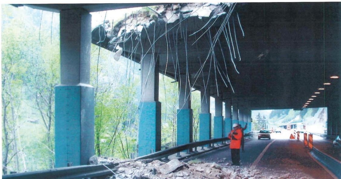
1.14 N2 Galerie Ripplista, Steinschlag 2004. Stein 20m<sup>3</sup>, Durchschlag des Galeriedaches zwischen zwei Querträgern
