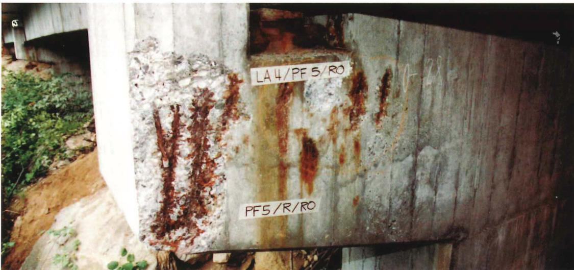
1.6 N2 Lehnenviadukt Wassnerwald, Auflager und Querträger über den Pfeilern, Korrosion und Abplatzungen
