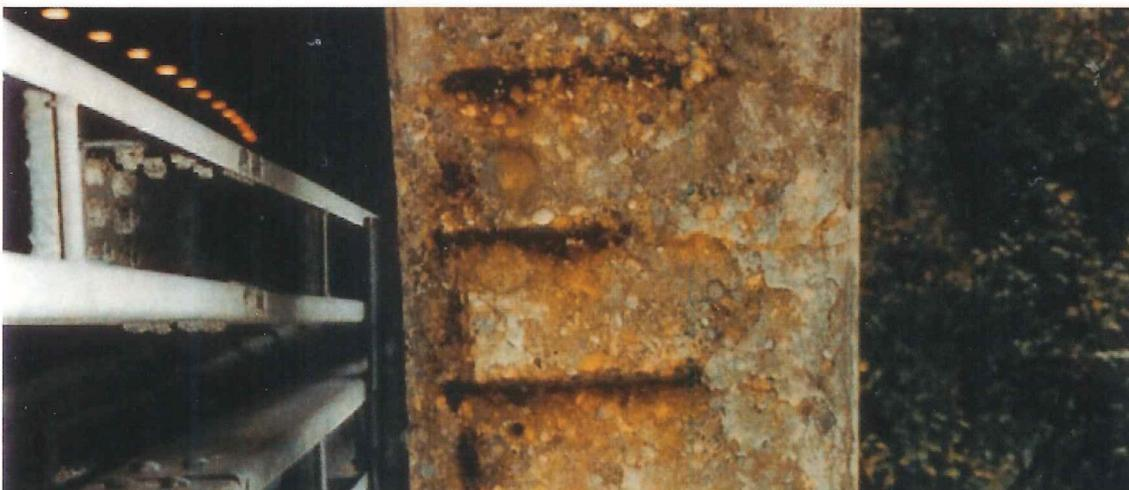
1.12 N2 Galerien, Korrosion der Stützen aus Salzeinwirkung neben der Fahrbahn
