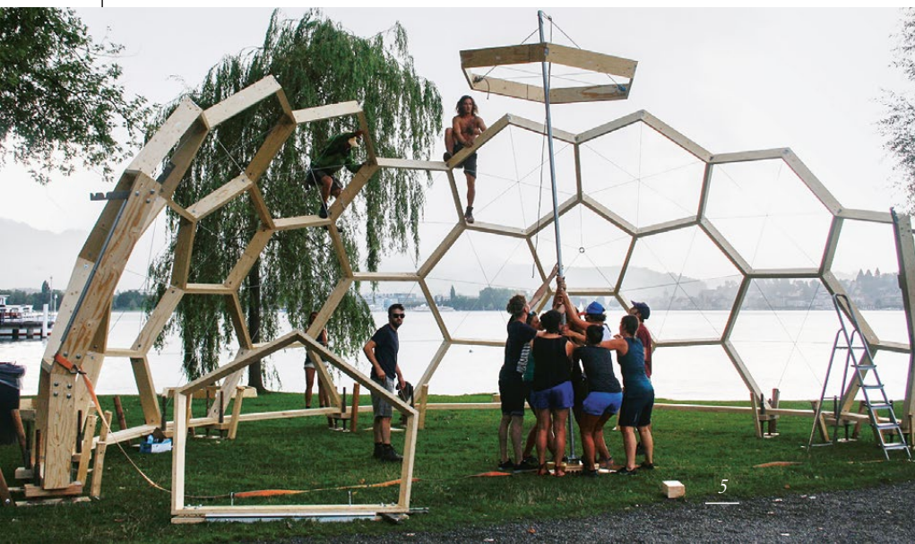
| Toiture de scène du NON-OpenAir, Meggen.
