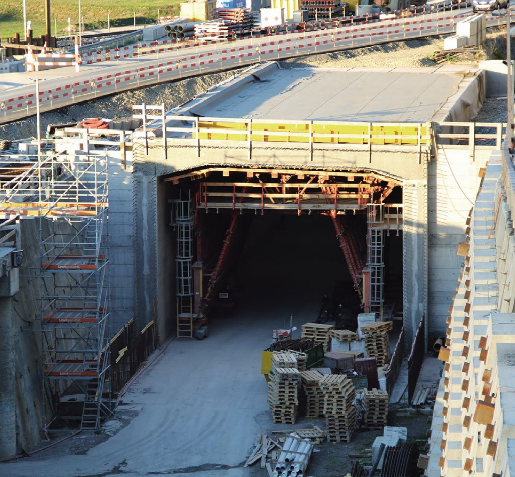
Construction du tunnel à ciel ouvert. À droite, les ancrages de sécurisation de la pente.
