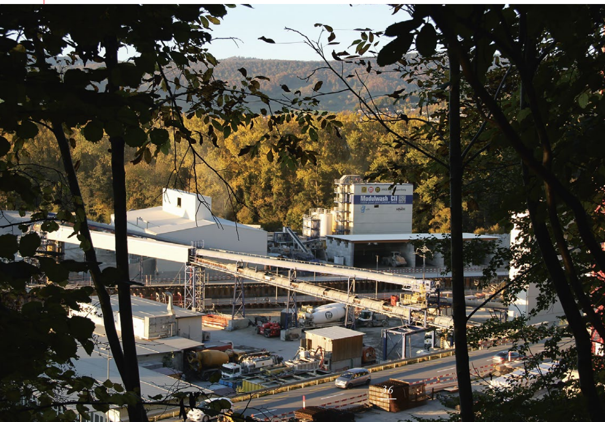
Vue de la halle de dépôt des matériaux excavés.
