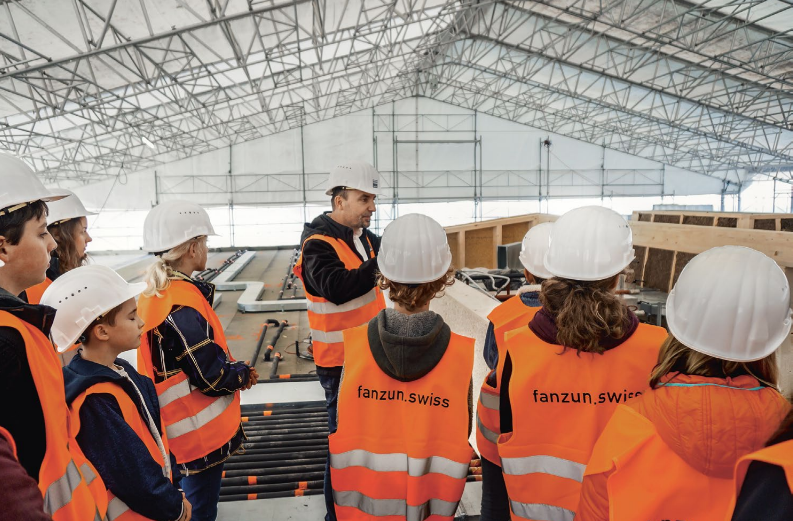
Mathias Barth, membre de la direction de Fanzun AG, conduit les enfants à travers le chantier de l'Oblamatik.
