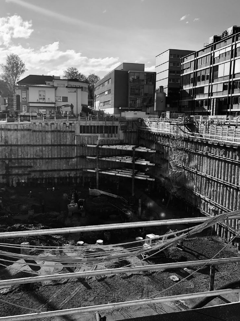
Chantier «secteur 12» de l'Hôpital de l'Île à Berne.
