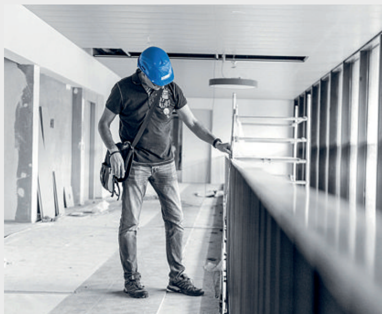
Contrôles de chantier.
