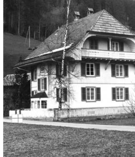
Premier local commercial à Trubschachen, avec une pièce en guise de bureau et un entrepôt dans la cave
