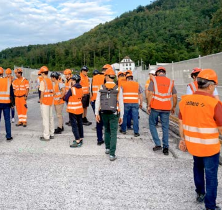
Le pont au-dessus de la ligne CFF
