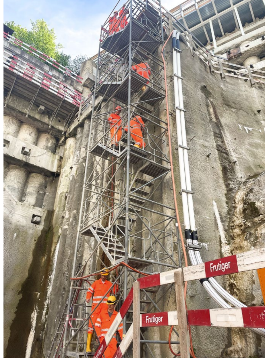
Point de descente dans la fouille
