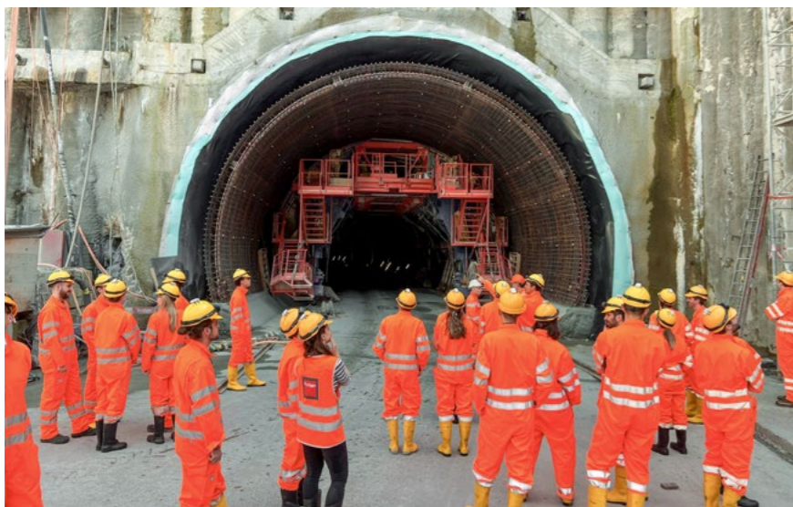
Point d'entrée vers les tronçons Bierhübéli et Henkerbrännli
