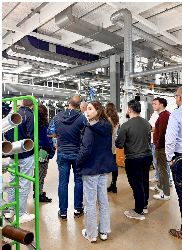
Besichtigung der Energiezentrale und Produktionsanlagen in Emmen
